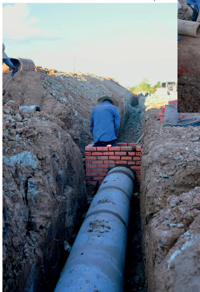
Operários estão trabalhando na drenagem e instalações das tubulações para a irrigação de um dos campos
